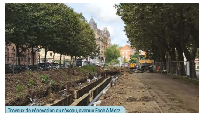
Travaux de rénovation du réseau, avenue Foch à Metz
