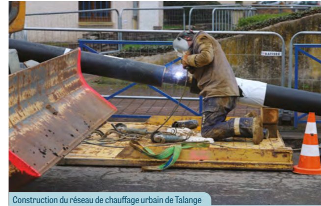
Construction du réseau de chauffage urbain de Talange
