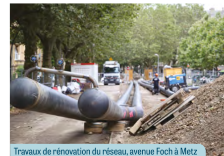
Travaux de rénovation du réseau, avenue Foch à Metz
